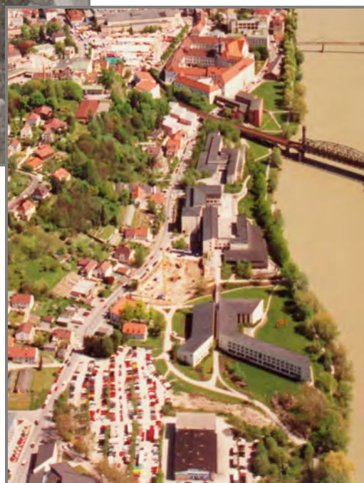
Luftbild nach 1993 neues Universitätsgebäude Kunsterziehung und Baustelle Audimax
